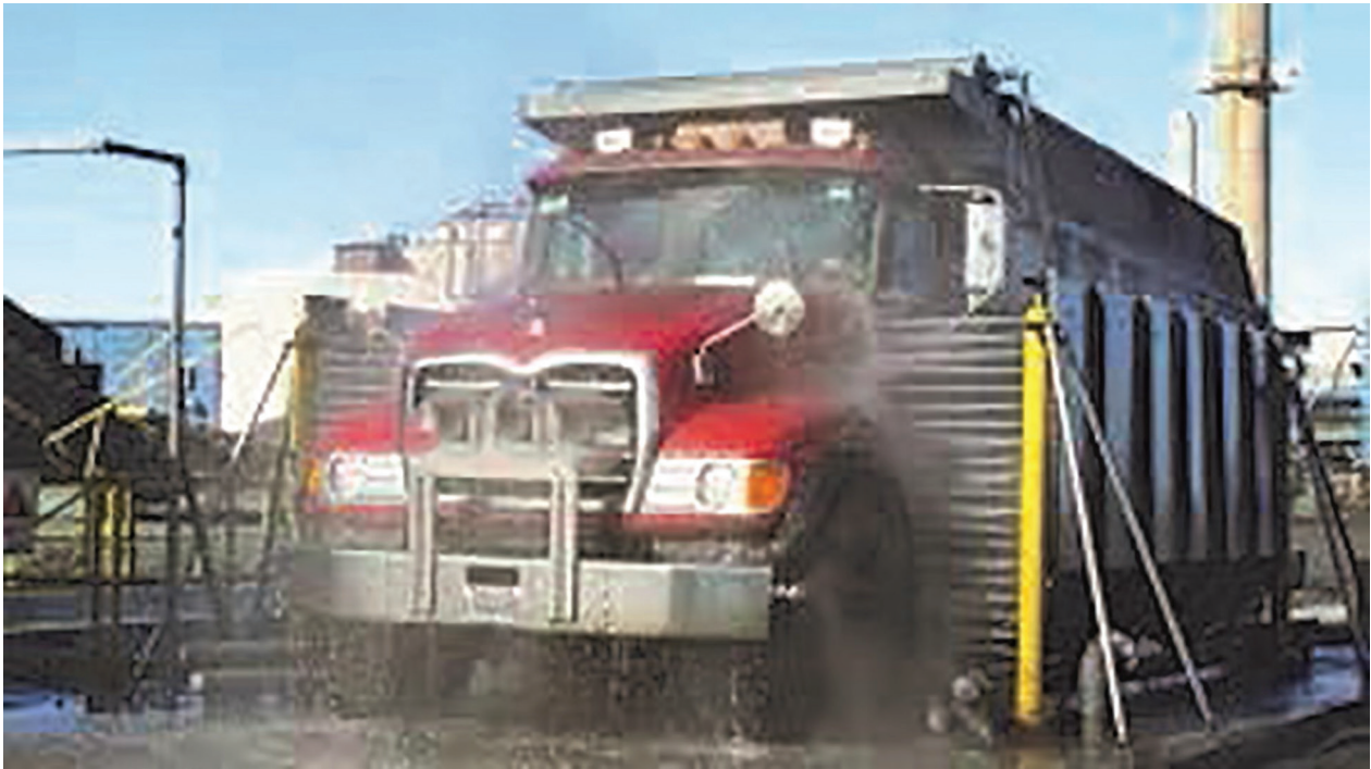
Зураг 32.Машин механизмын дугуй угаах 1-р арга: Зөөврийн автомат тоног төхөөрөмж ашиглан усаар тоос шороог шүршиж арилгах /Жишээ зураг/
